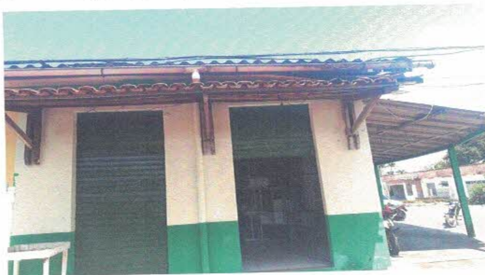
Figura 1 –Vista frontal da edificação
